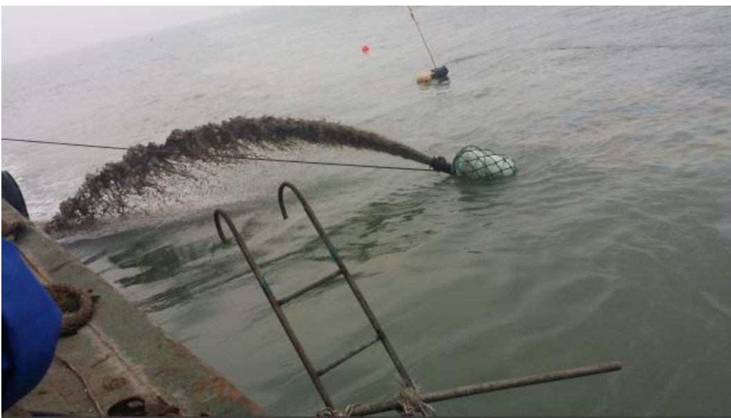
泥浆泵清沙（减轻沉船重量）
