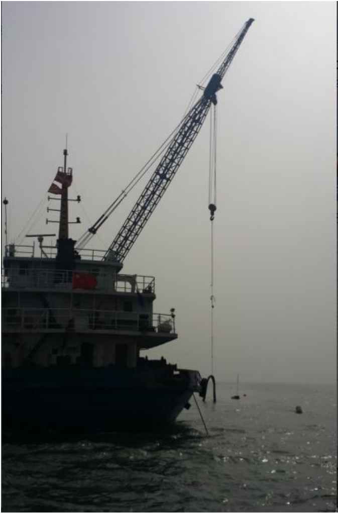
吊机吊放泥浆泵至潜水员指定位置
